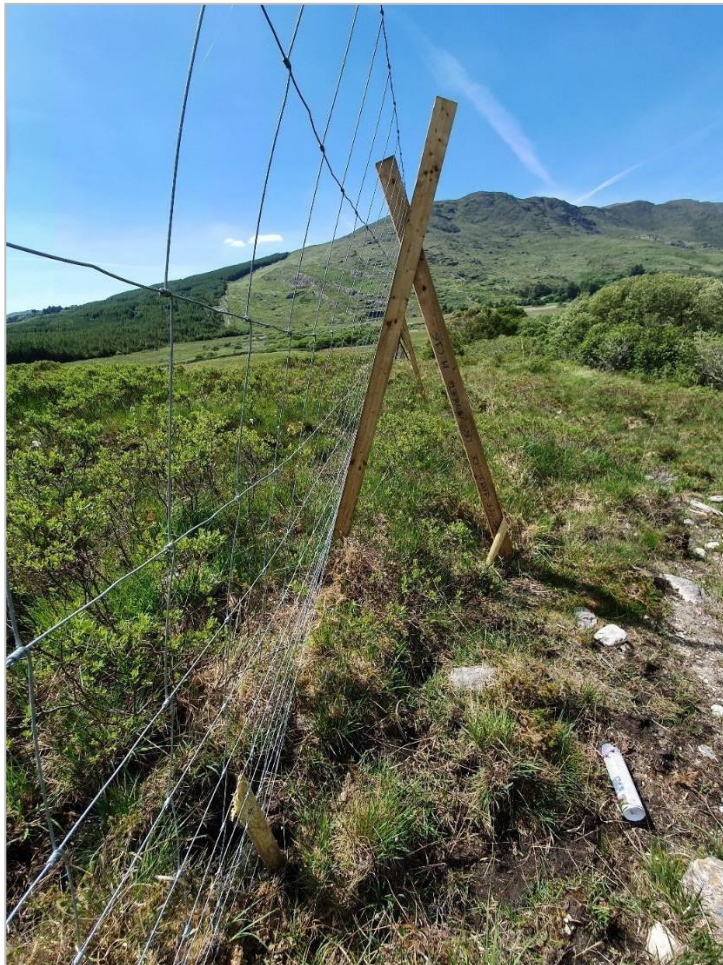
Pláta 13. Mionsonraí fál A-fráma ag taispeáint crochadh liontáin agus cuaille go talamh. Grianghraf le Paddy Purser.
